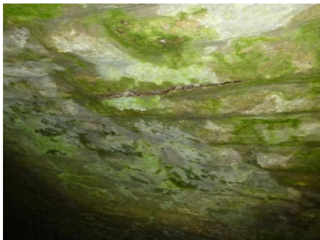
uvolněný materiál spar na konci
