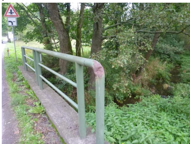
poškozené zábradlí vpravo
