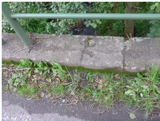
trhliny v římsách
